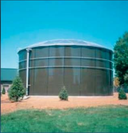
Tanque de armazenagem térreo
