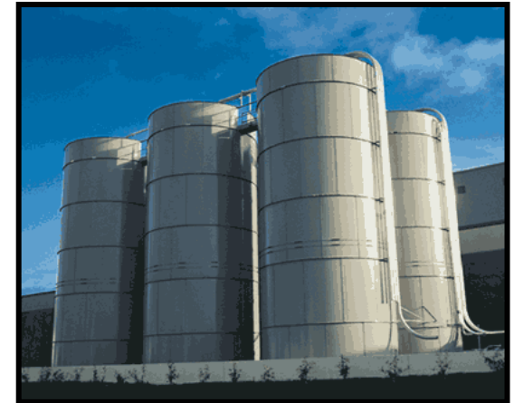
Silos con faldón.
