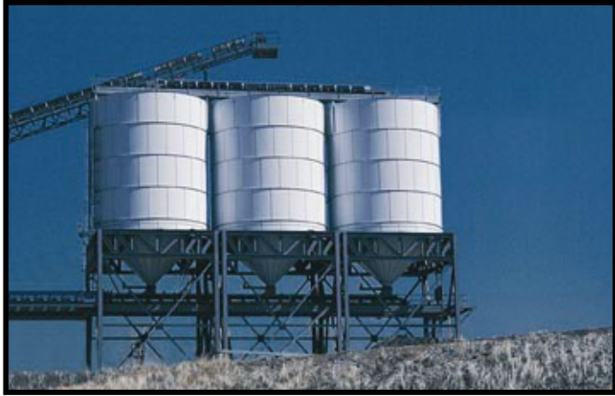
Silos con fondo cónico sobre soportes estructurales
