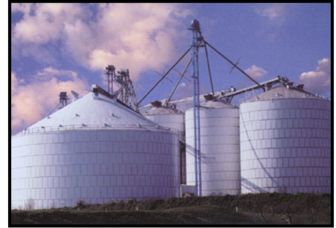
Silos con fondo plano y gran diámetro
