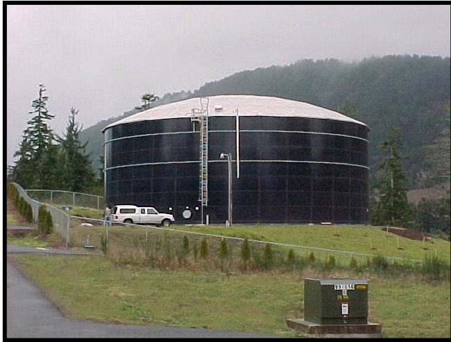
Depósito con techo en cúpula
