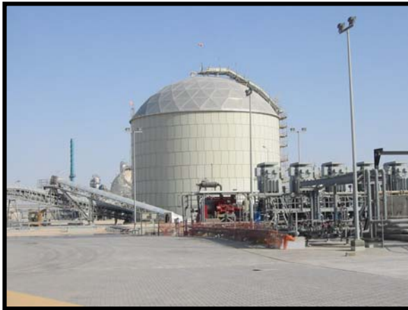
Silo con fondo plano y con techo de cúpula geodésica de aluminio
