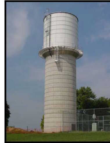
Tanque elevado sobre torre de hormigón
